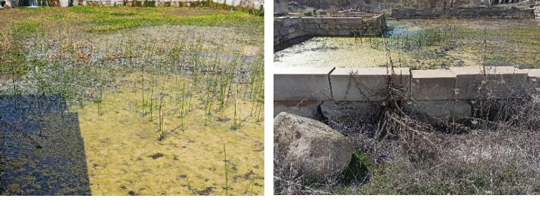
Şekil 7. 8. 9. 10. 11. 12. EPHSA Havuzunda Görülen Bazı Aksaklıklar
